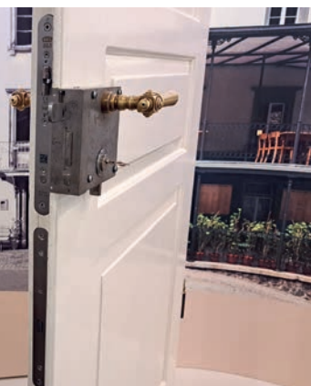
Mittels App lässt sich über das Steuermodul «Lotta» (unten) das Kastenschloss mit dem Einsteckschloss verbinden.
